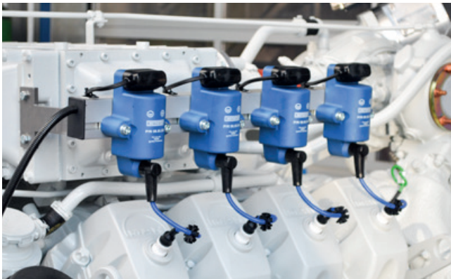
Schienenmontage am Ladeluftkühler
